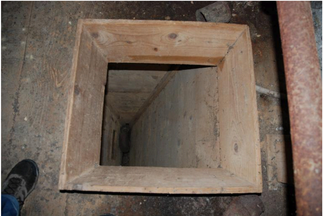
Vue intérieure du 1er étage, partie nord : entonnoir à grain pour approvisionner la meule.
