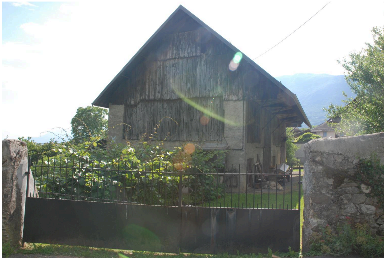
Partie sud. Grange-étable (2018 E2 479). Trumeaux maçonnés, bardage de planches.
