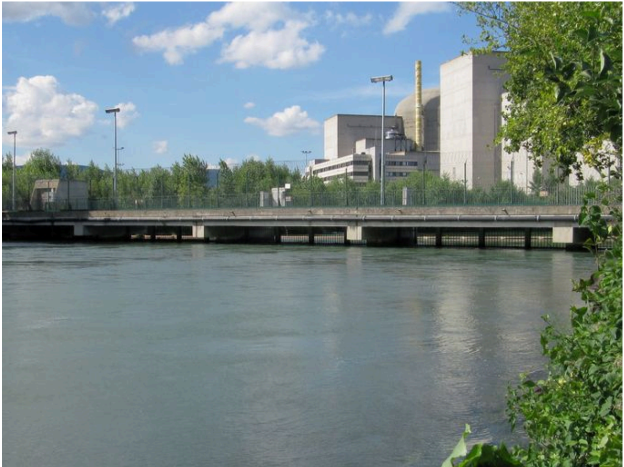
Premier ponceau : vue générale, face amont
