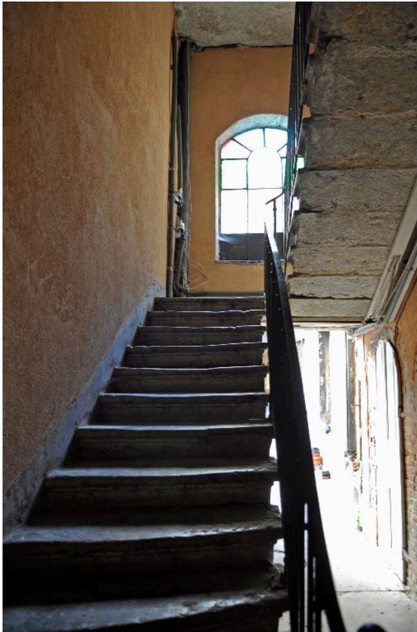
Vue intérieure : l'escalier
