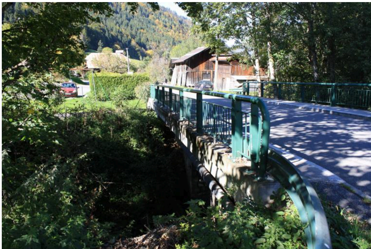
Pont d'Essert-Romand, chaussée et garde-corps
