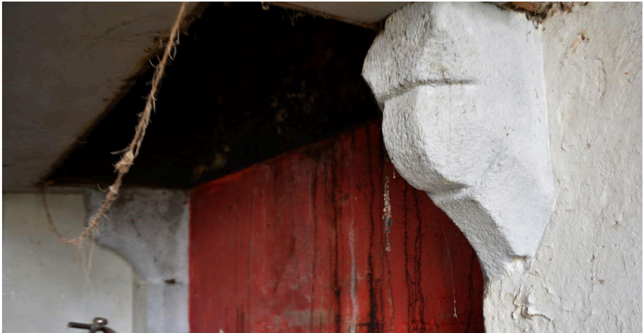
Vue d'un des corbeaux moulurés de la cheminée septentrionale.
