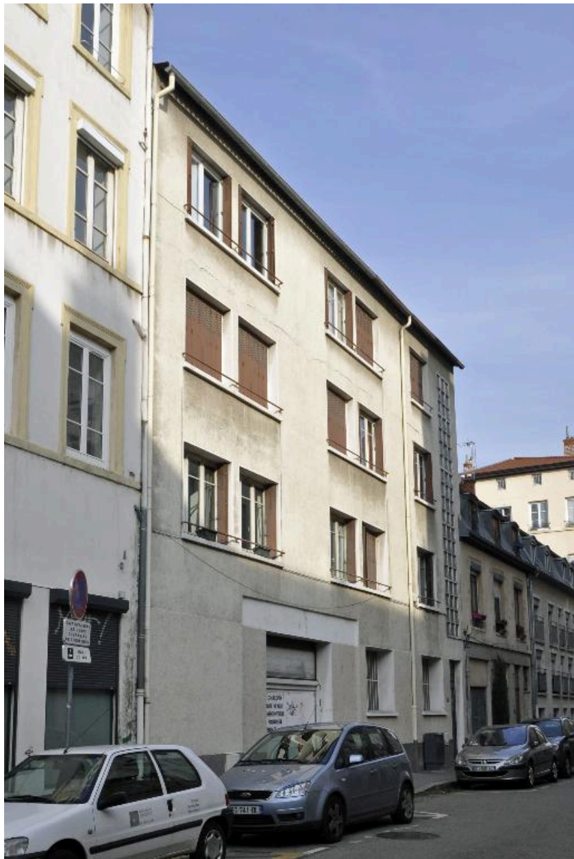
Elévation sur rue, vue générale
