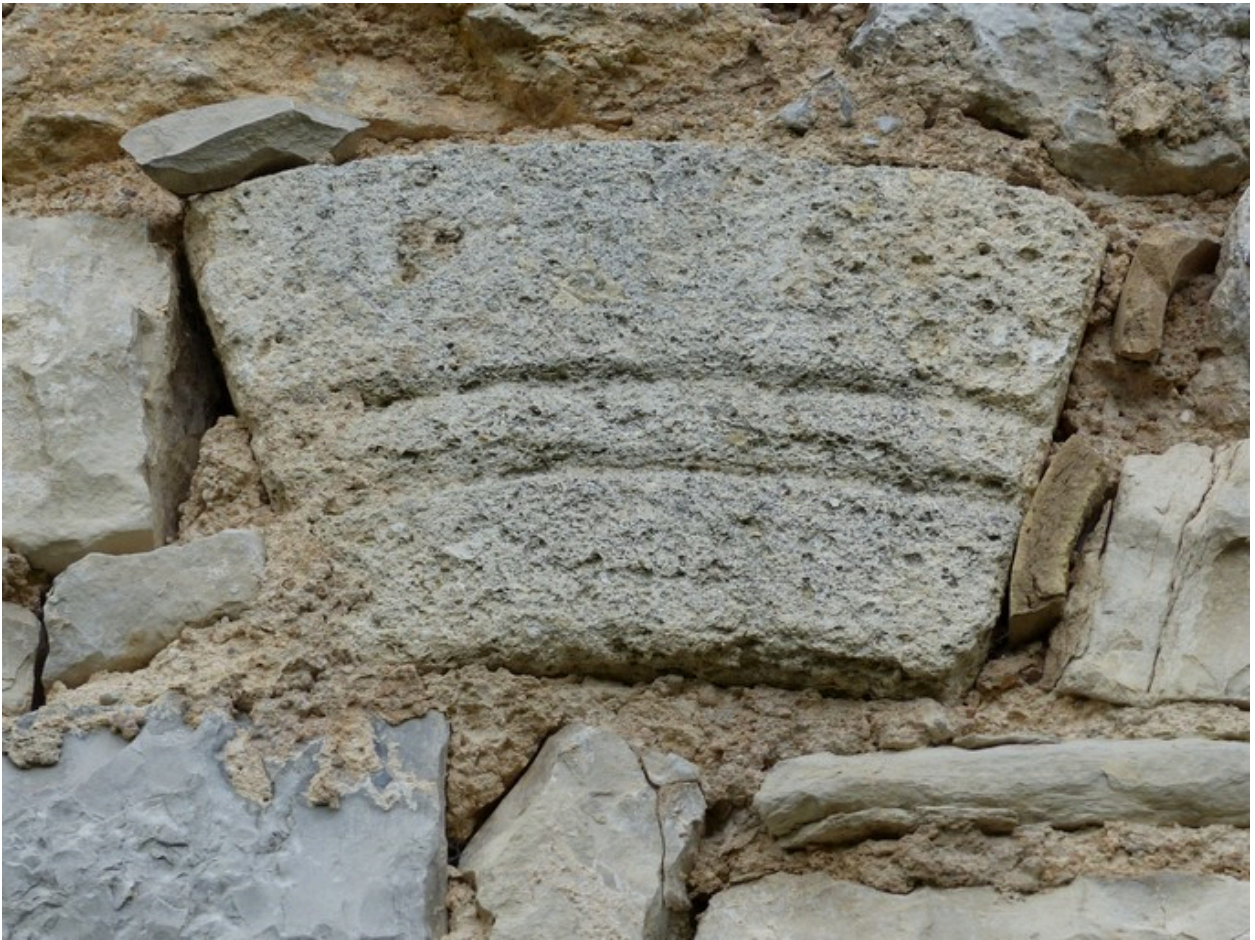
Pignon sud, claveau en pierre de taille de tuf, décoré, en rempli.
