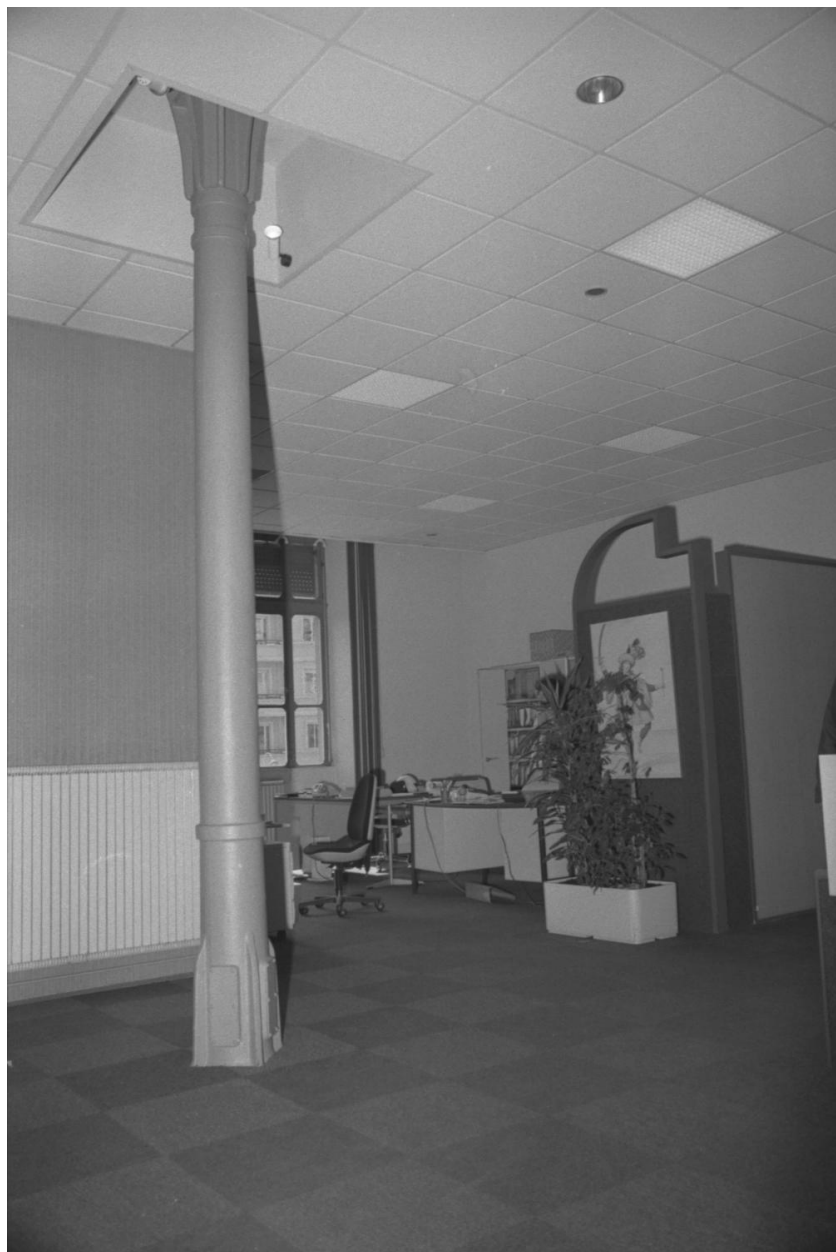
Bureau. Faux plafond. Pavillon EG, 1er étage
