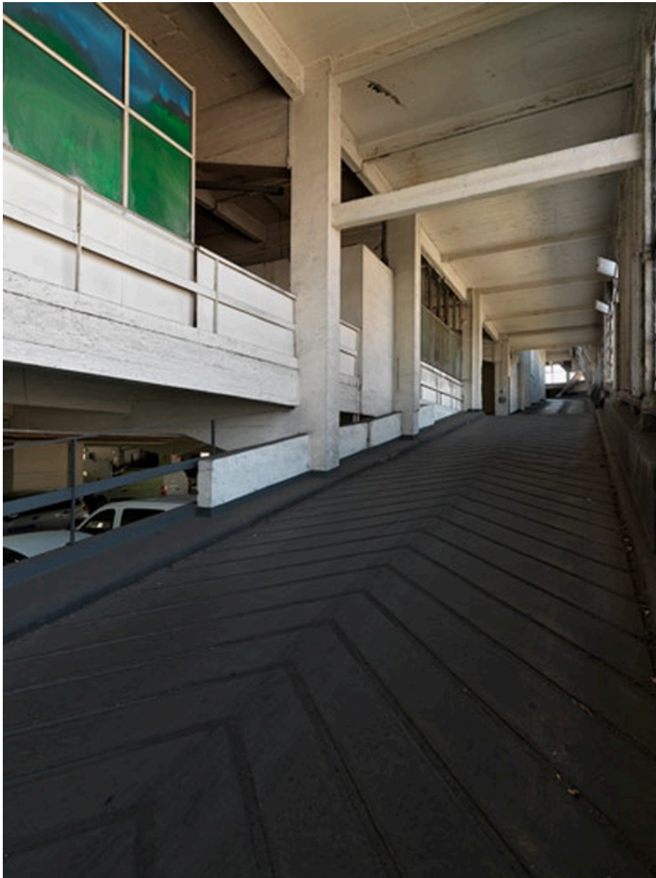
Rampe montante, lisibilité des poteaux-poutres et plafonds
