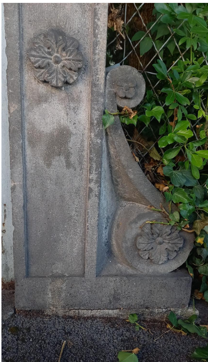
Détail du pilier de la porte piétonne sans couverture
