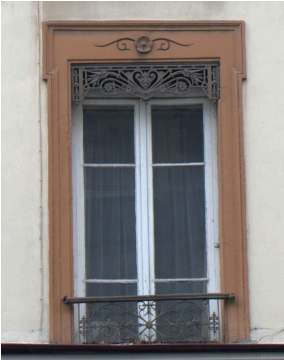
Détail d'une fenêtre
