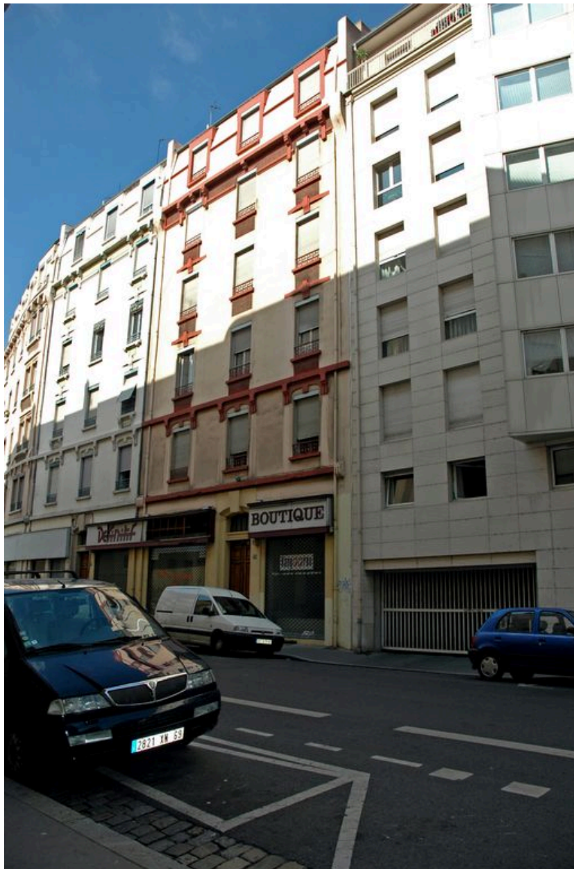
Vue d'ensemble des 270-272 depuis le nord-est
