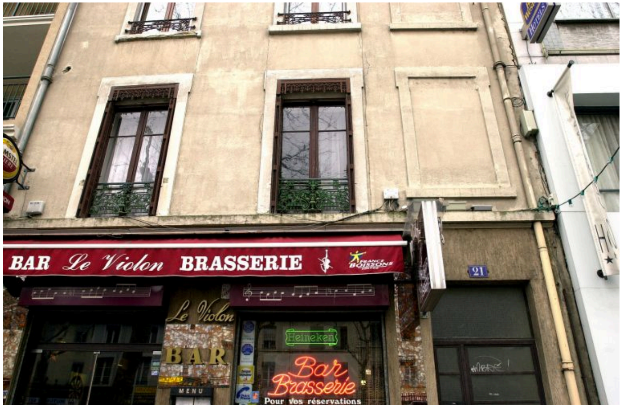
Détail des fenêtres sur rue
