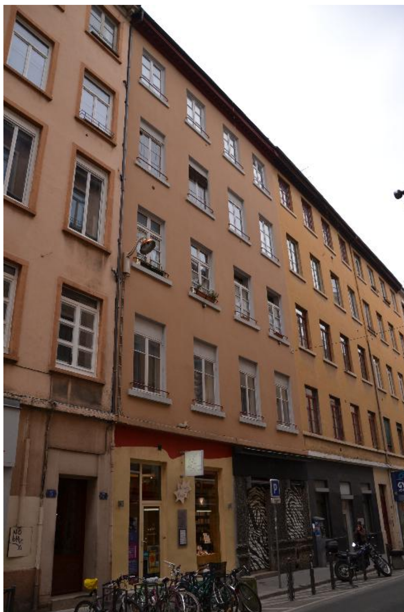
Vue d'ensemble façade sud
