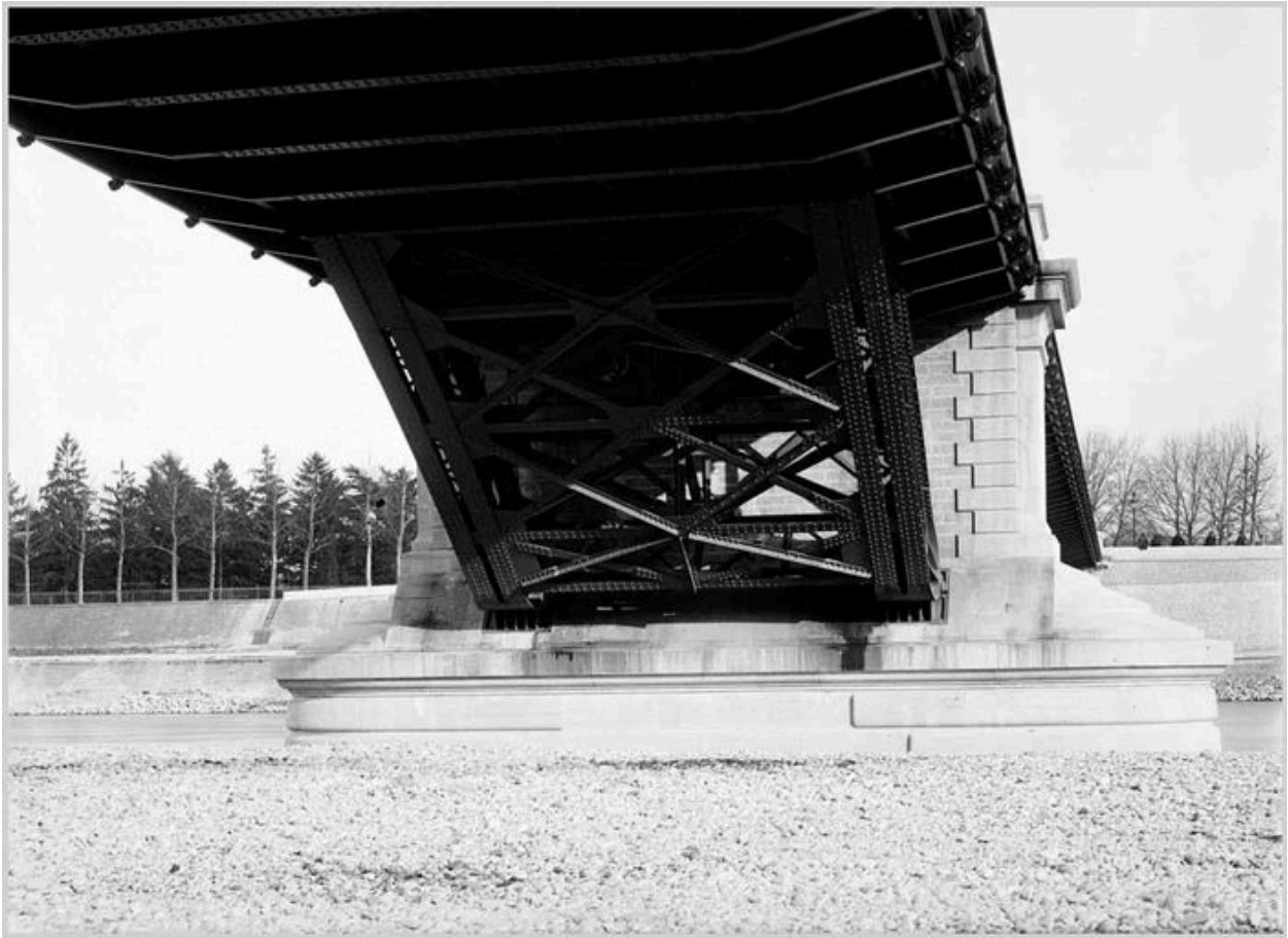
Le pont de la Boucle achevé. Vue d'une pile depuis l'îlot central, côté ouest. [1903]. 1 photogr. : n. et b. (AM Lyon. 15 Ph 1842)
