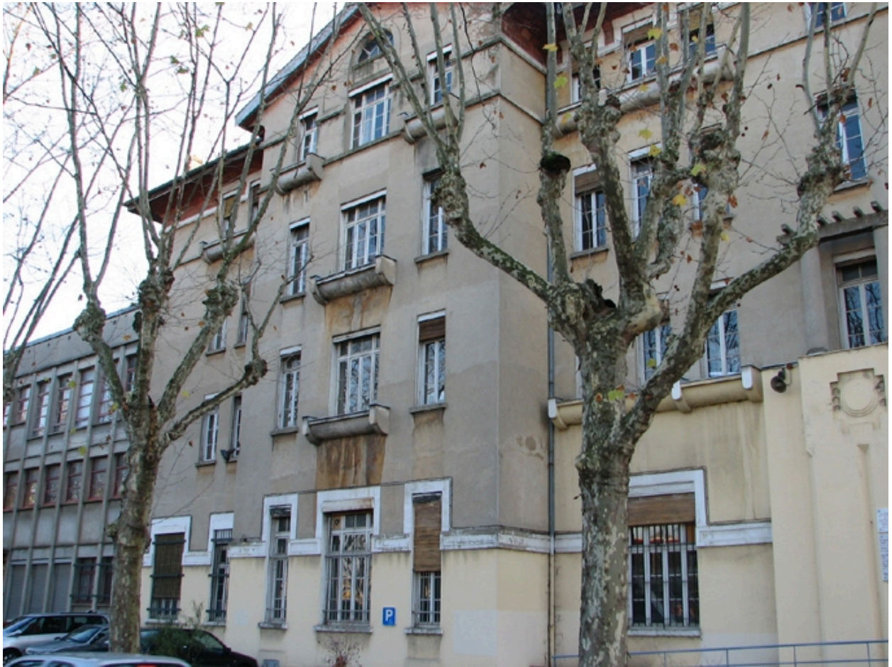
Détail avant-corps de bâtiment
