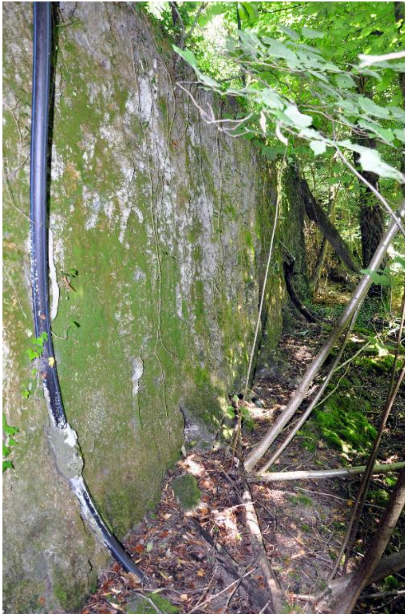
Vue de l'un des murs de la réserve d'eau.
