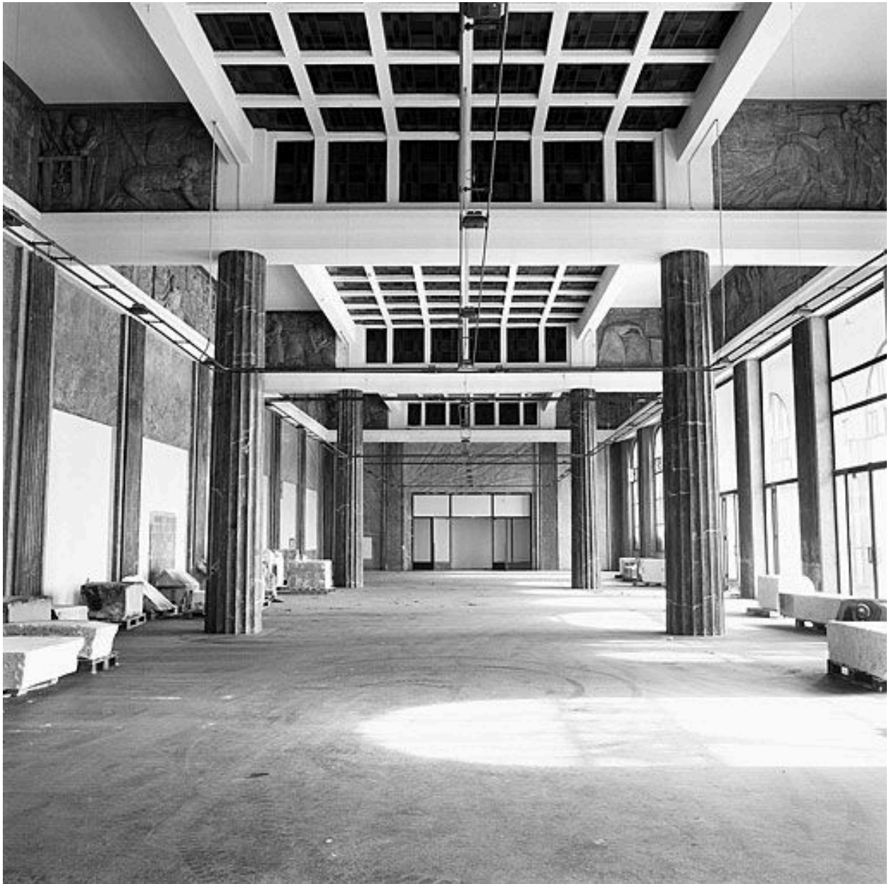
Vue générale de l'atrium
