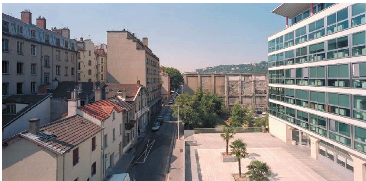
Vue générale depuis le toit du collège Jean-Monnet au nord
