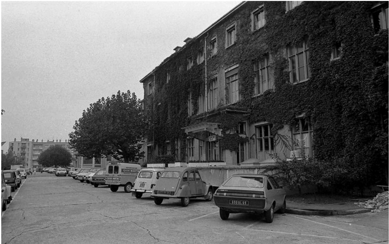
Pavillon S. Elévation nord. Photogr., 3e quart 20e siècle
