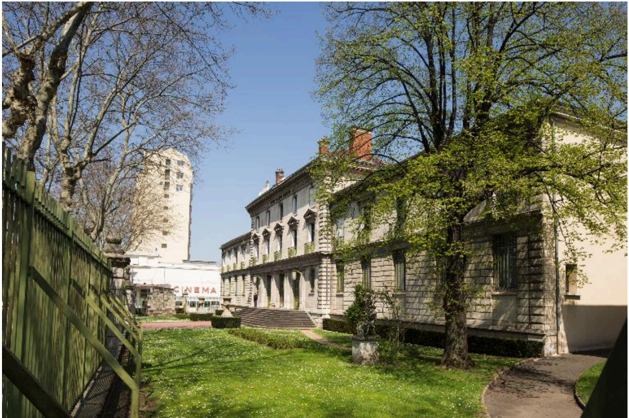
Vue de la façade principale du bâtiment A. Orientation est-ouest
