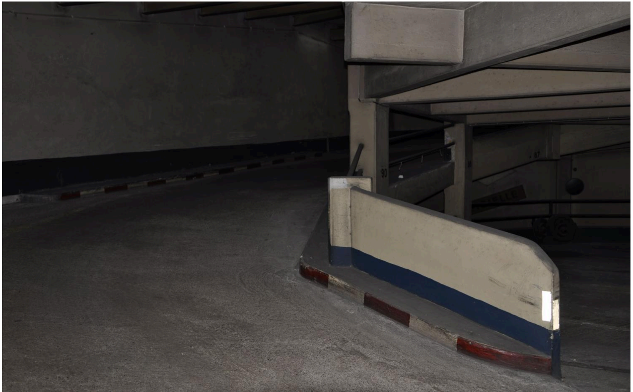
Vue intérieure du parking souterrain avec rampe d'accès
