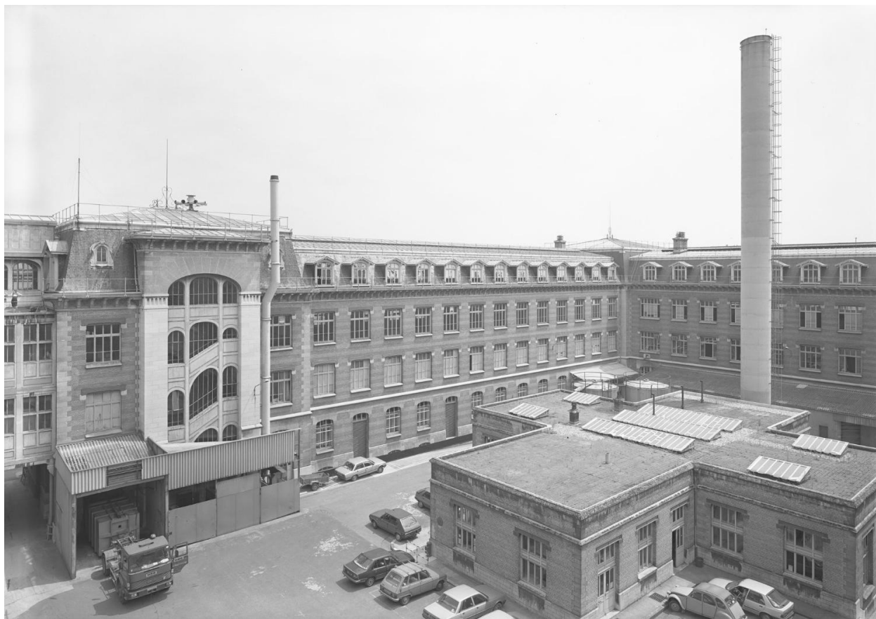
Cour intérieur sud, vue depuis l'angle nord-ouest. Bâtiment H (service d'entretien) et cheminée
