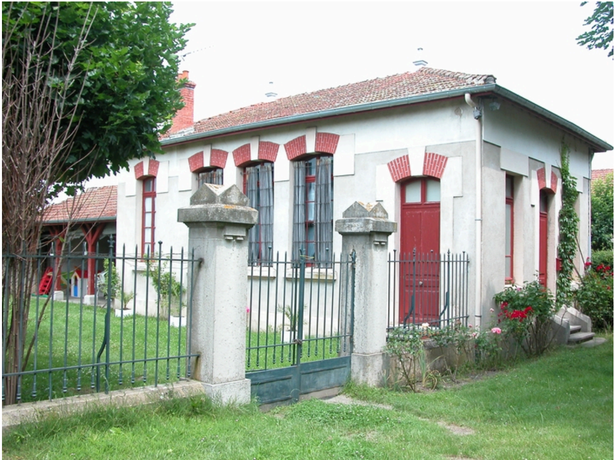
Vue d'ensemble du bâtiment ouest, depuis le sud-ouest.
