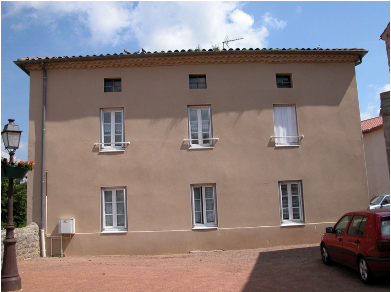
Vue de l'élévation sud.
