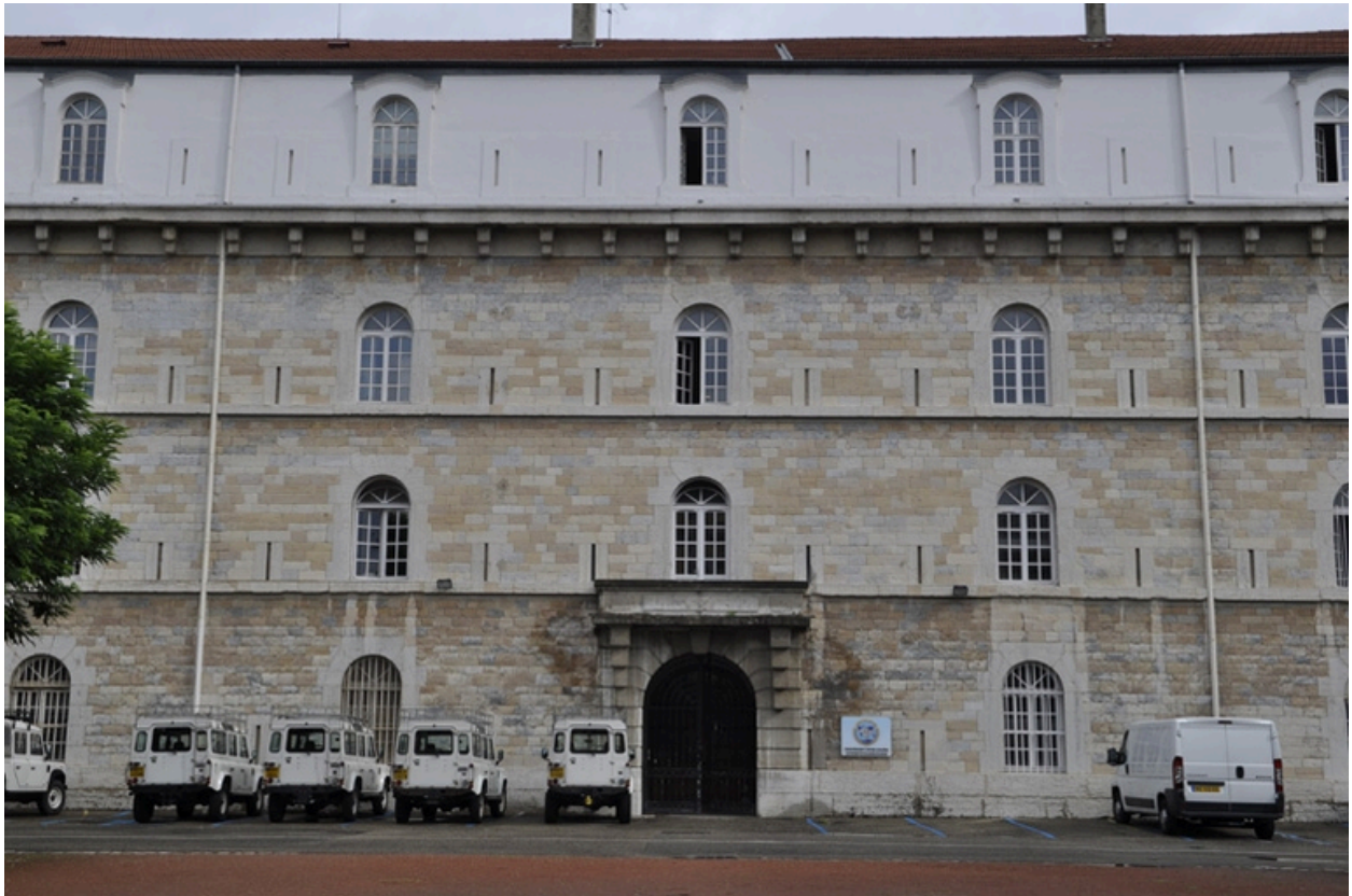
Vue du bâtiment principal, façade Sud.
