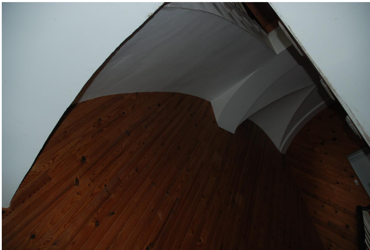
Demeure, vue intérieure : détail du voûtement de l'escalier.
