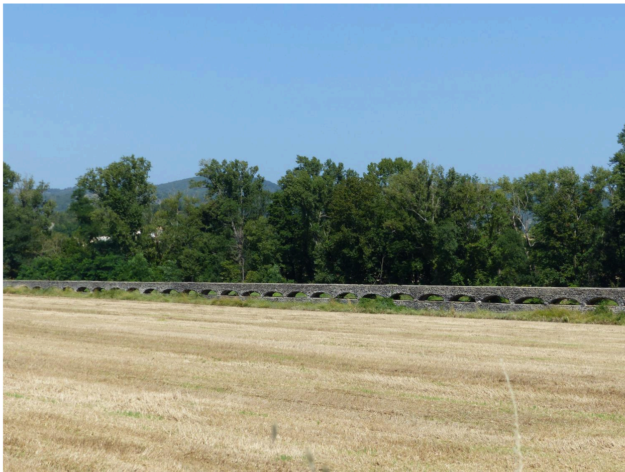
Vue d'ensemble de l'aqueduc dans un grand paysage
