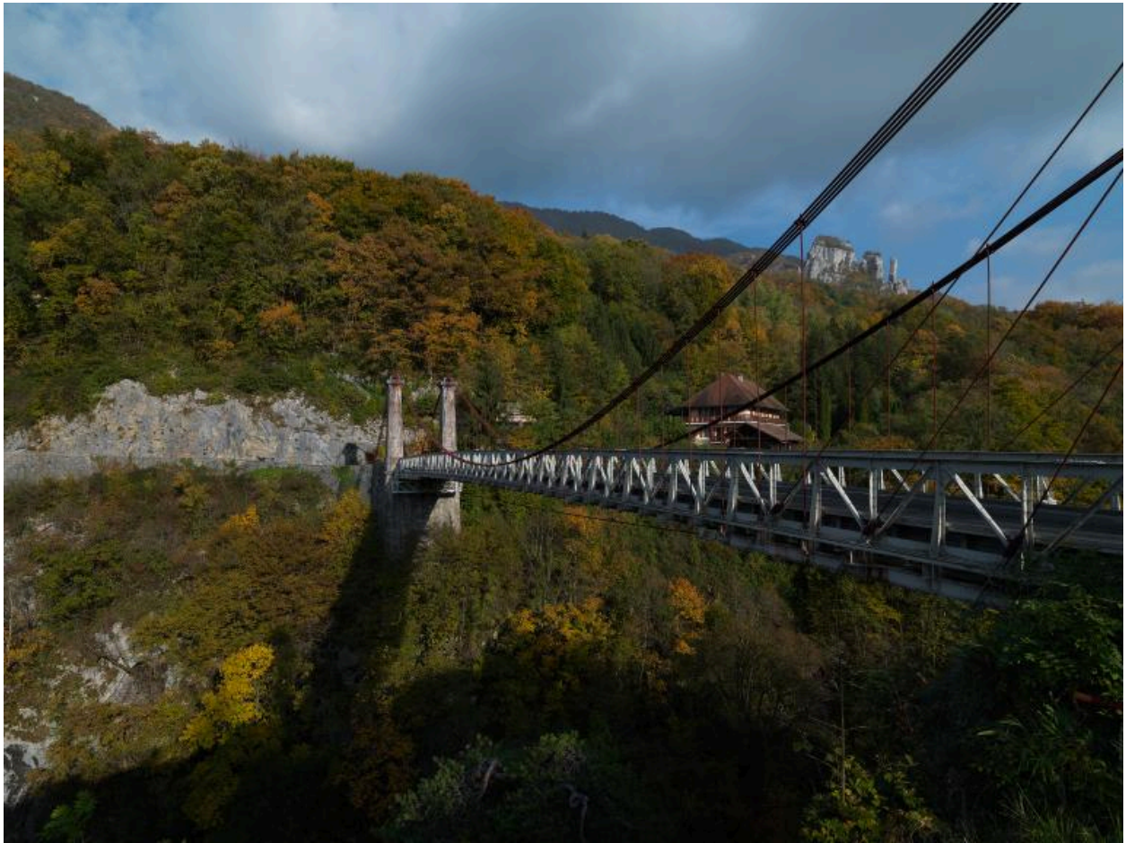
Vue partielle du pont prise depuis Cusy.
