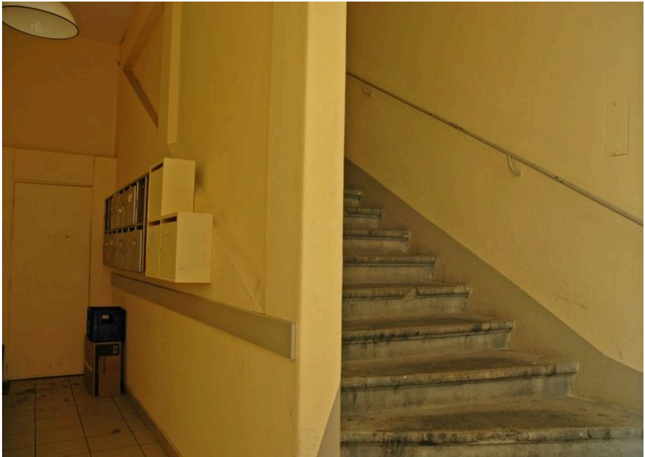
284 rue de Créqui : vestibule et 1ère volée d'escalier
