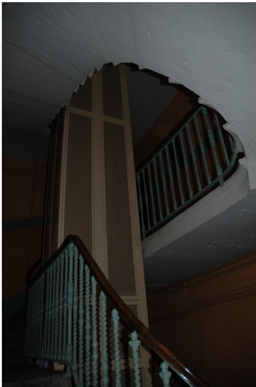
Détail de l'escalier et de l'ascenseur aménagé dans le noyau
