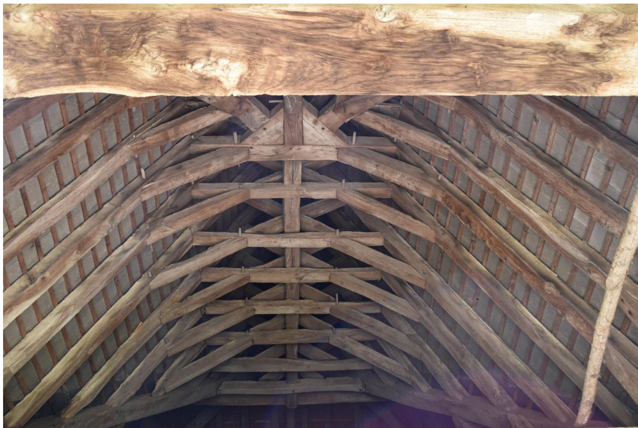
Charpente du auvent de la grange n°1
