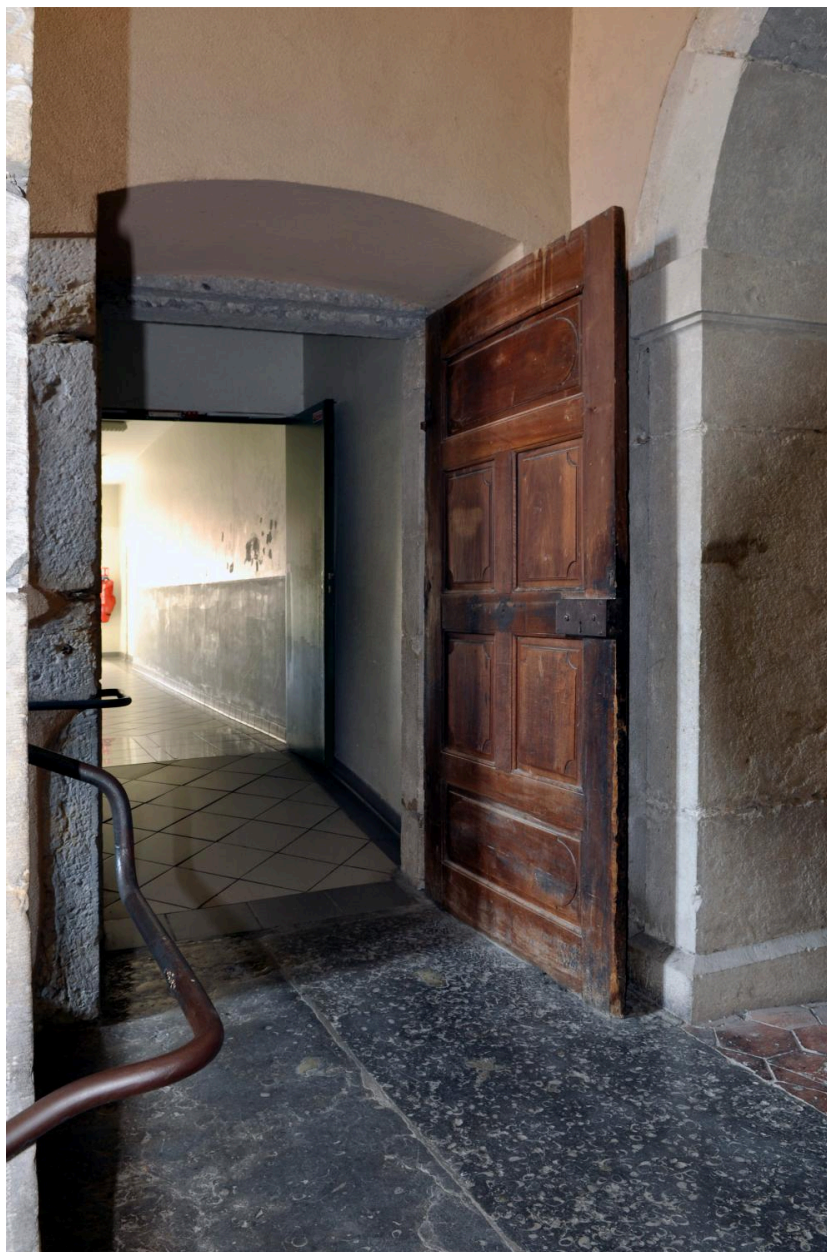
Bâtiment C : escalier G, palier du 1er étage, porte sud ; à droite de la porte : passage vers l'église
