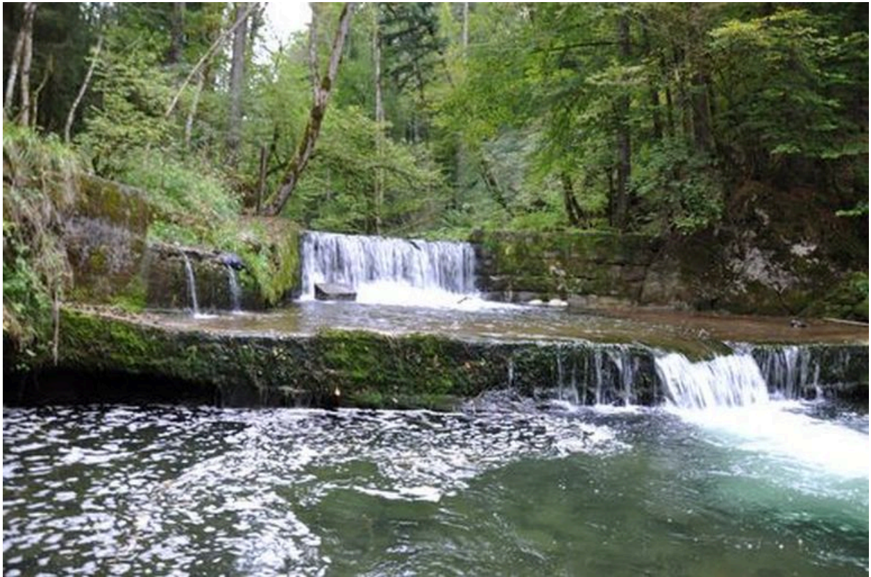
Double seuil du barrage
