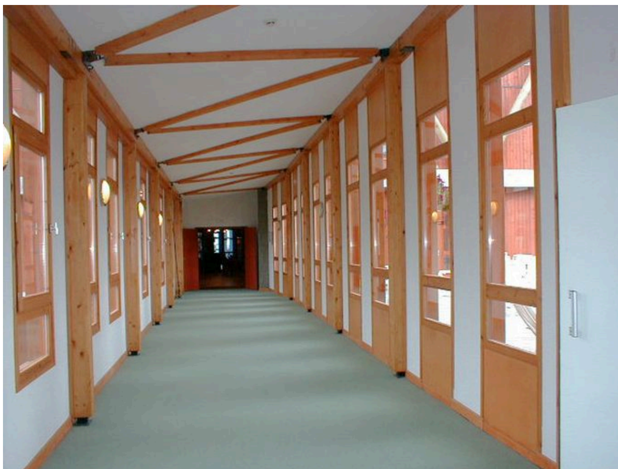
Coursive de liaison entre les parties communes et les studios
