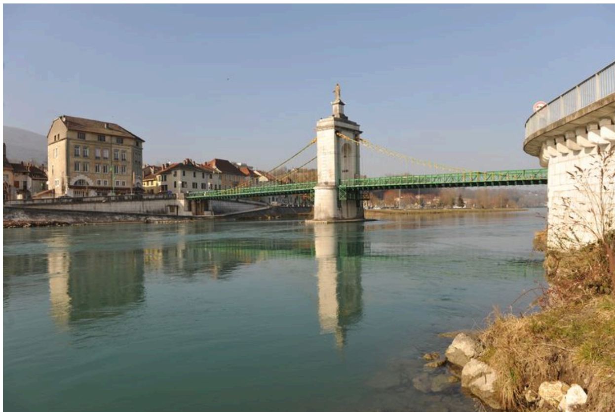
Vue générale, face amont (depuis la rive gauche)
