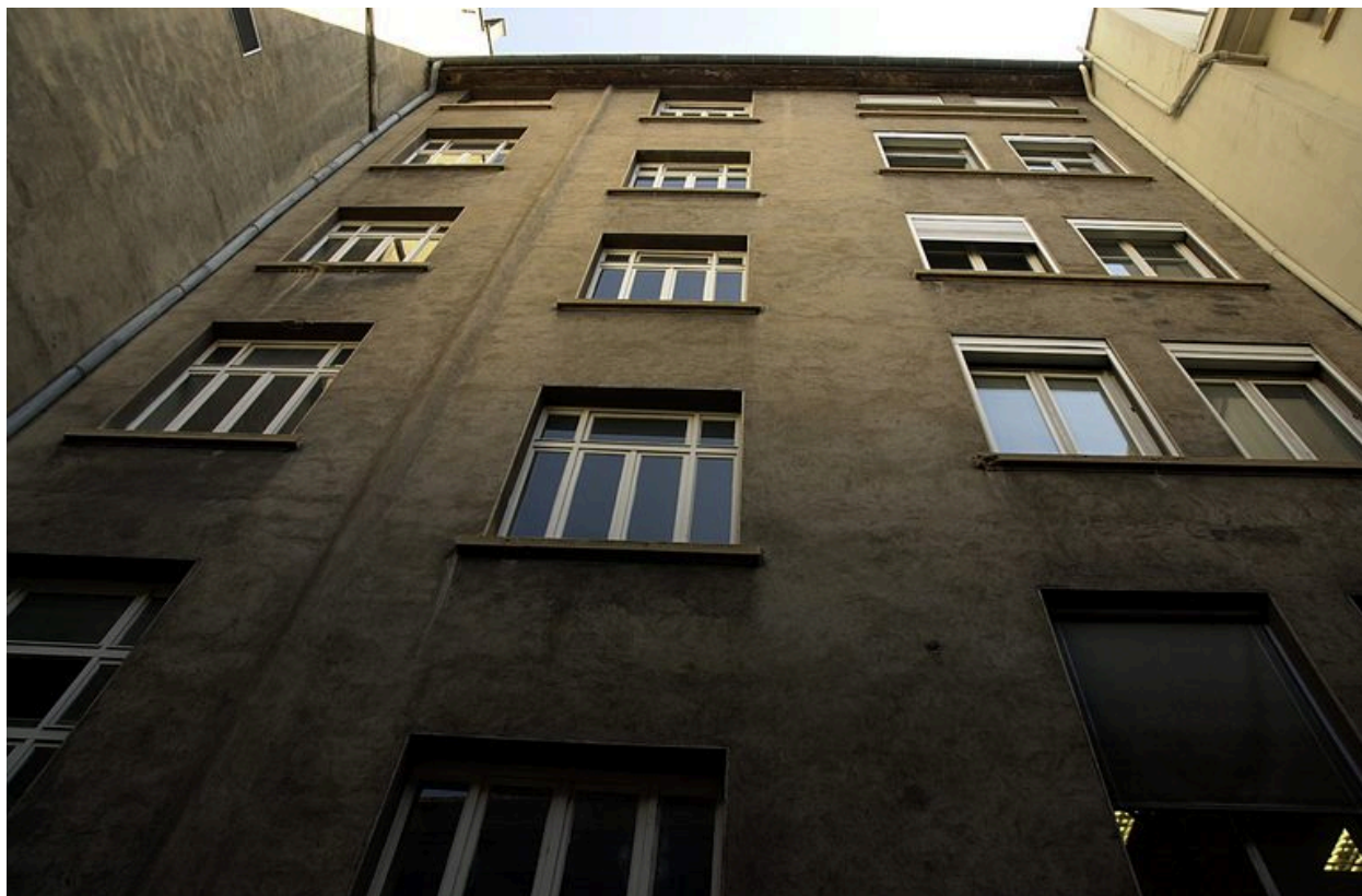
Cour derrière l'immeuble 12 rue du Port du Temple
