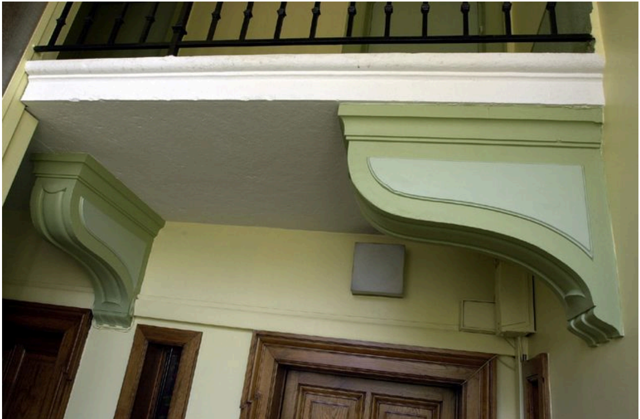
Détail des consoles supportant les paliers
