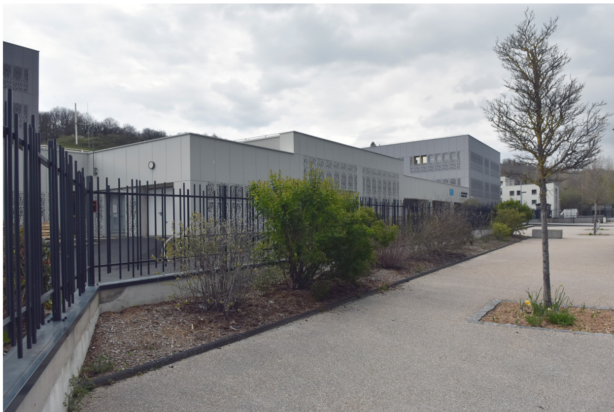
Vue de l'entrée, après travaux
