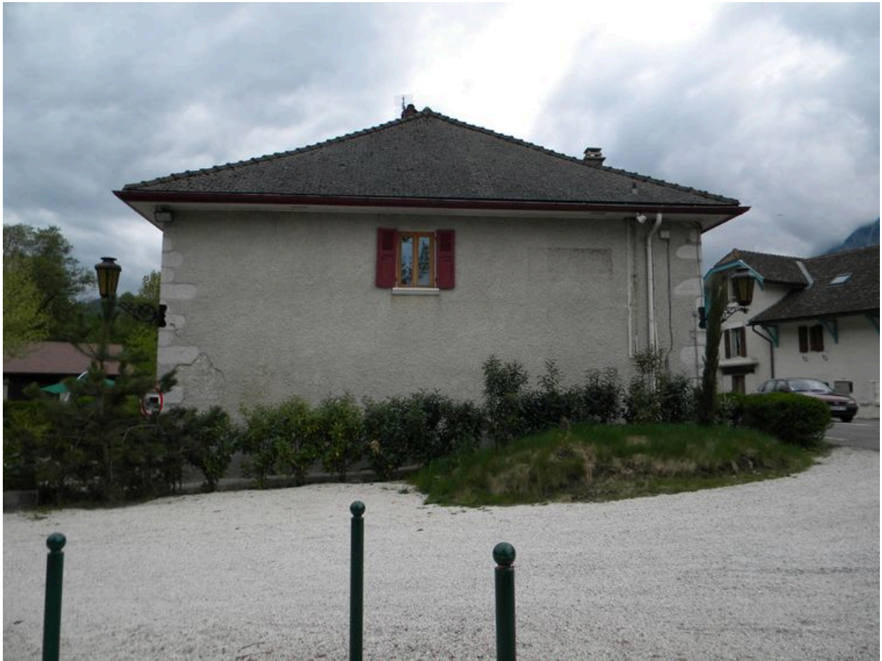
Vue du mur pignon nord.
