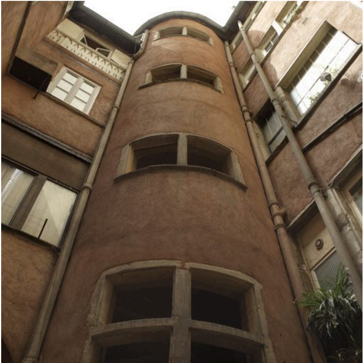
Partie supérieure de la cage d'escalier depuis la cour
