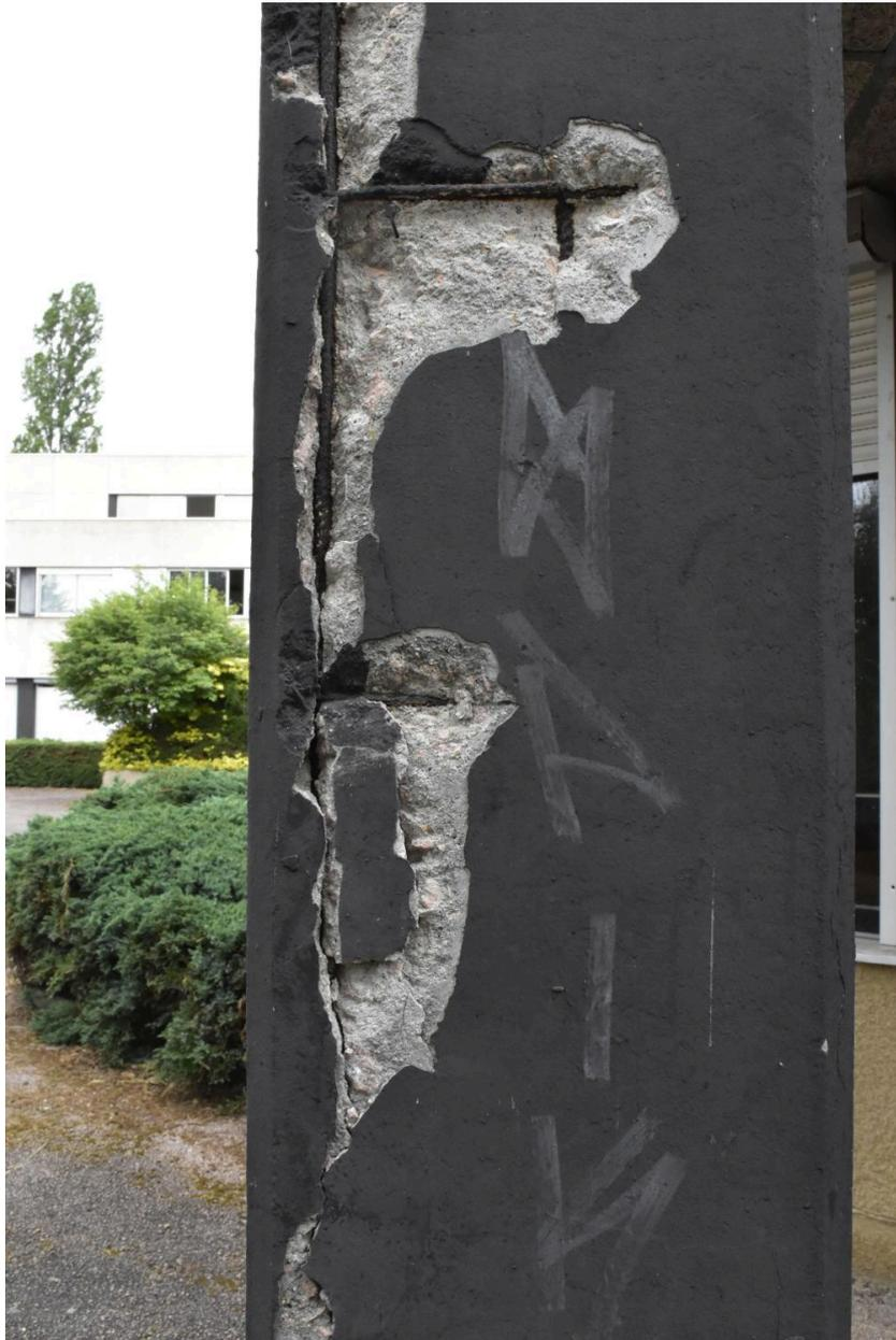
Détail d'un poteau en béton du bâtiment de l'externat et de son armature mise à nue.
