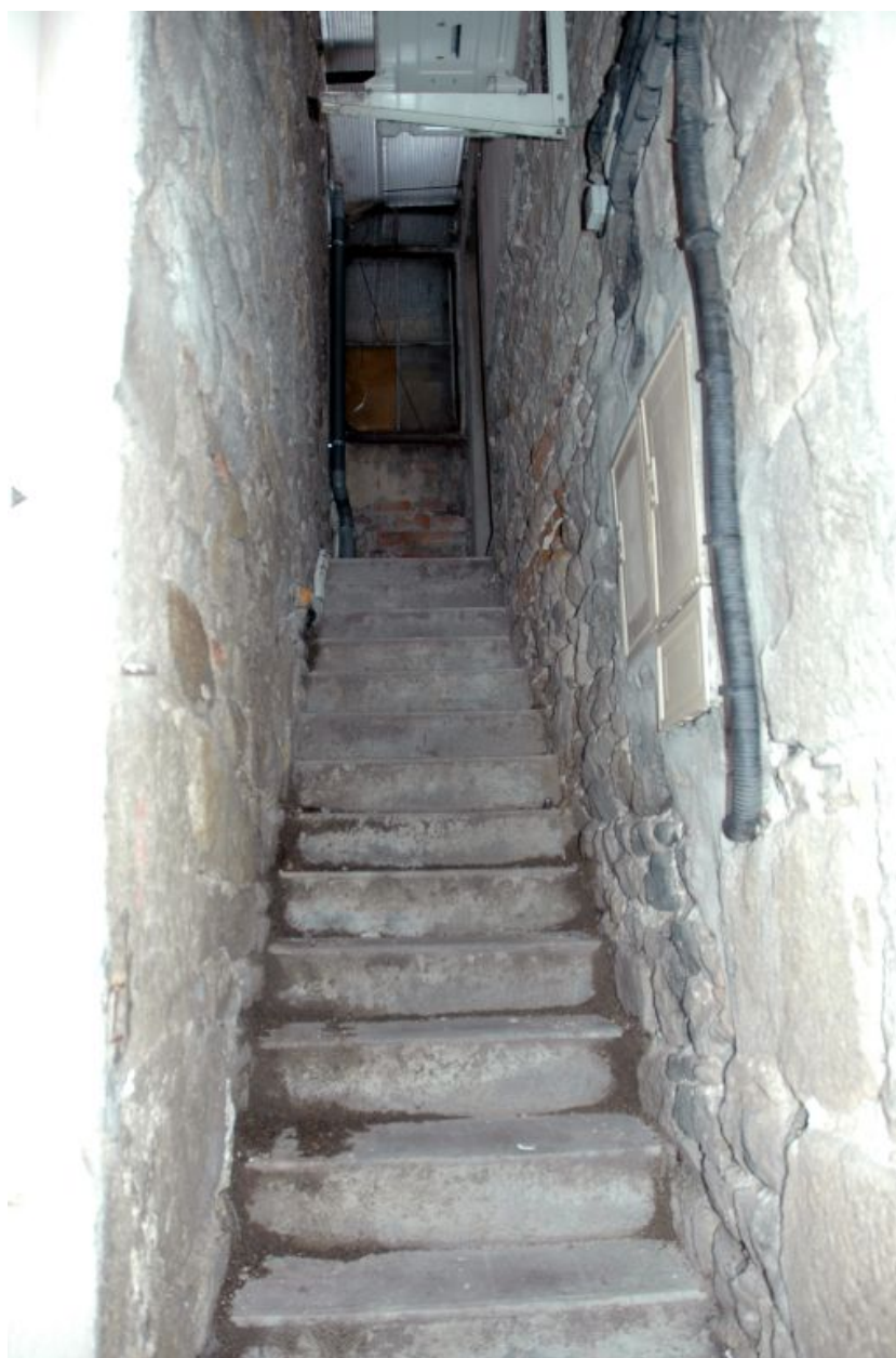
Ancienne venelle latrinale occupé par un escalier de distribution extérieur.
