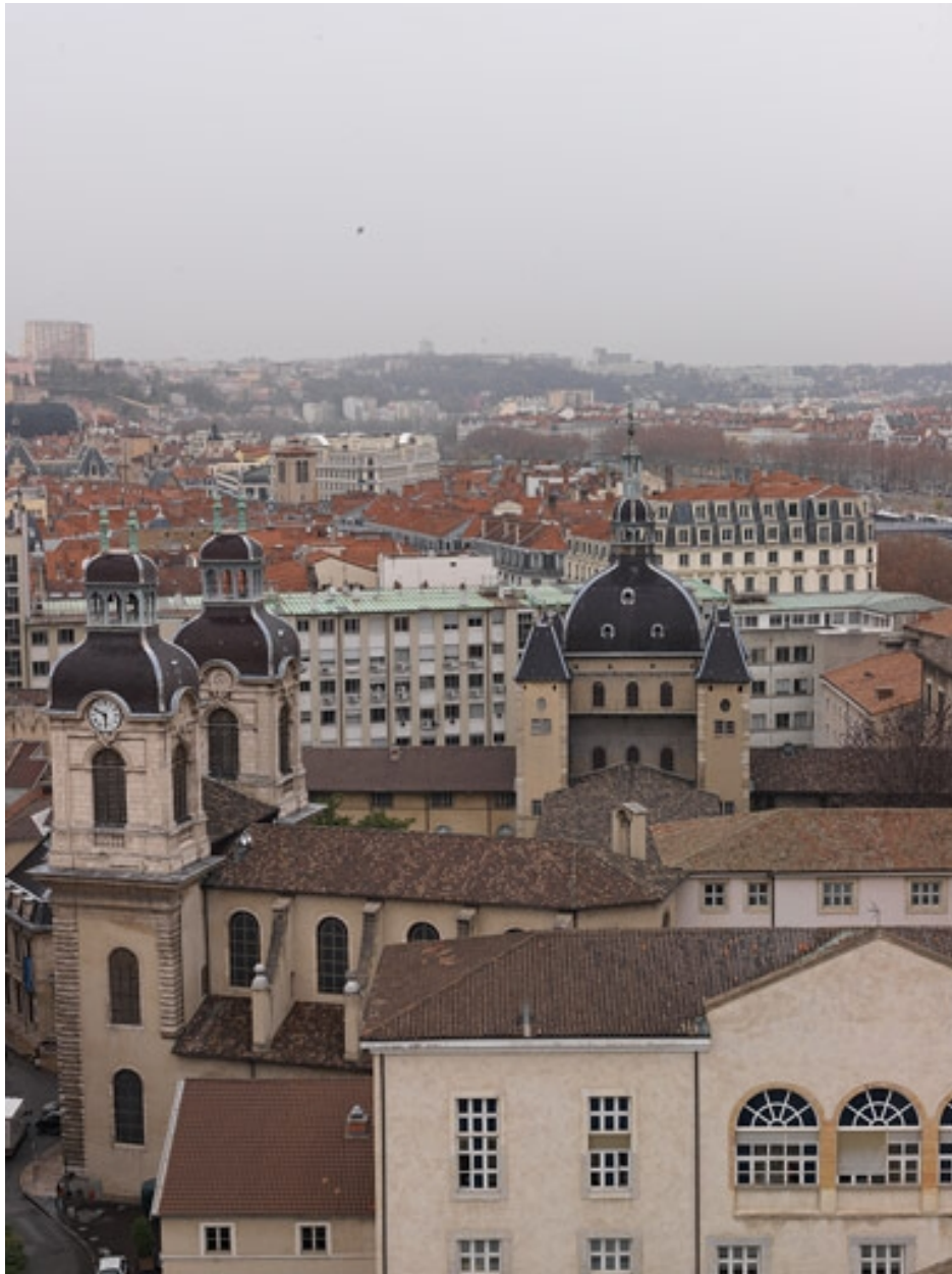
Le dôme des Quatre Rangs depuis le dôme Pascalon, au sud. A l'avant, la chapelle de l'hôpital et le bâtiment G
