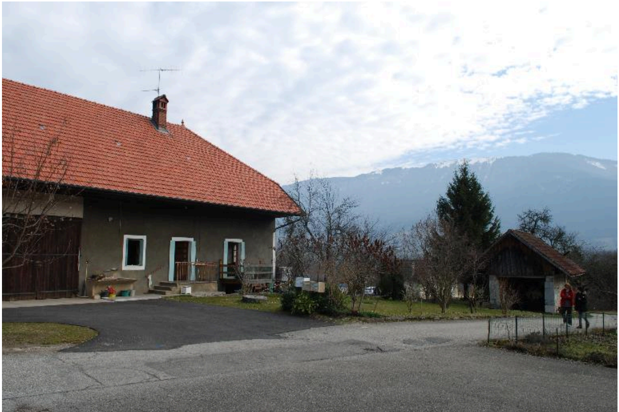
A1 936, 1130, Essert (I'), ferme. Vue partielle de l'extrémité est.
