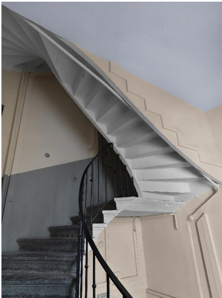
Escalier dernier niveau
