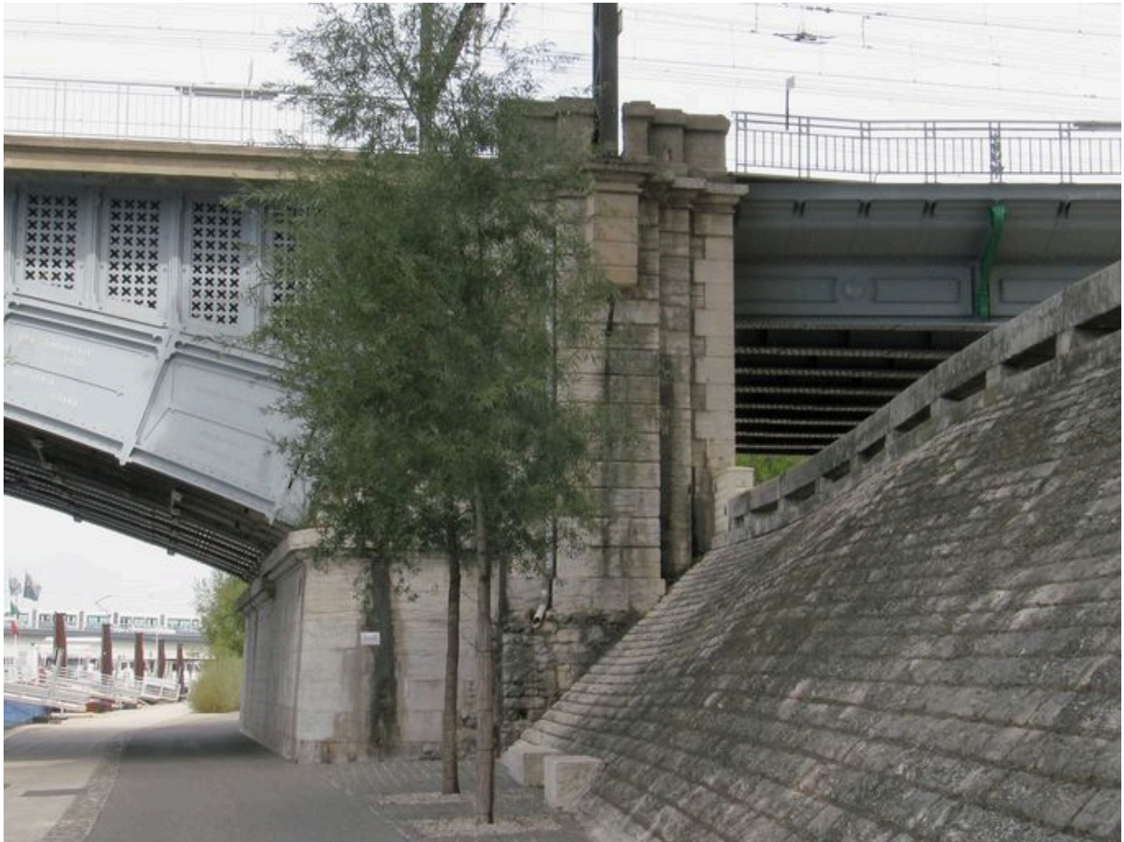
Culée gauche, face aval, vue générale (depuis la rive gauche)
