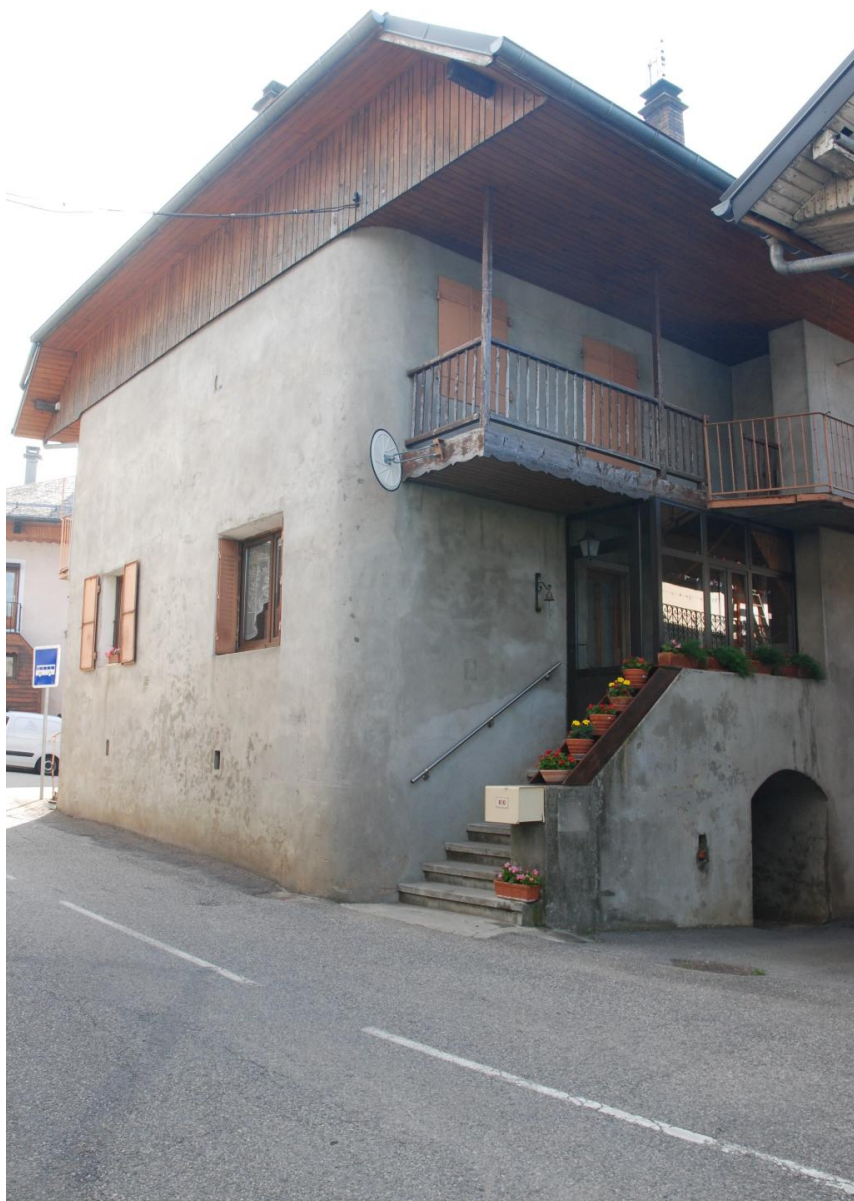
Maison de vigneron (2018 C2 407).
