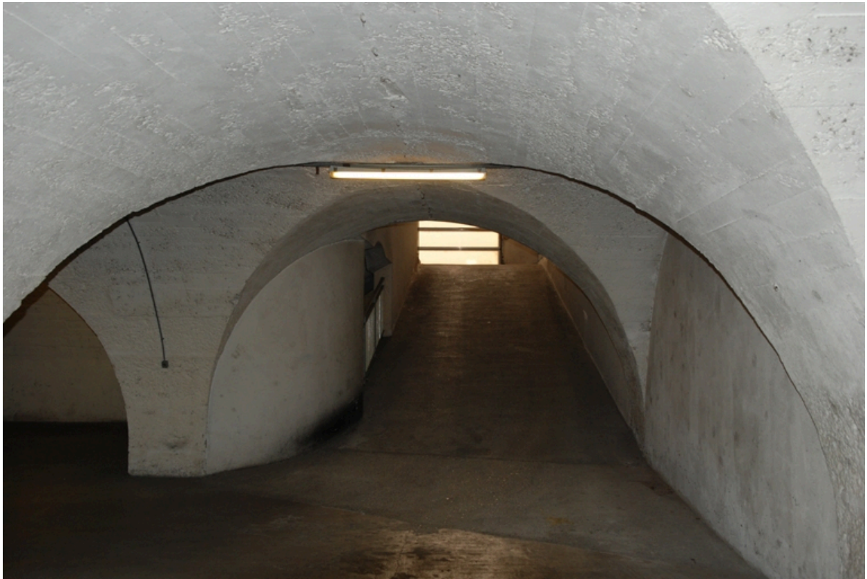
Sous-sol voûter : parking
